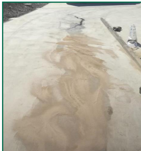
Fotografía 7. Aplicación sepiolita
