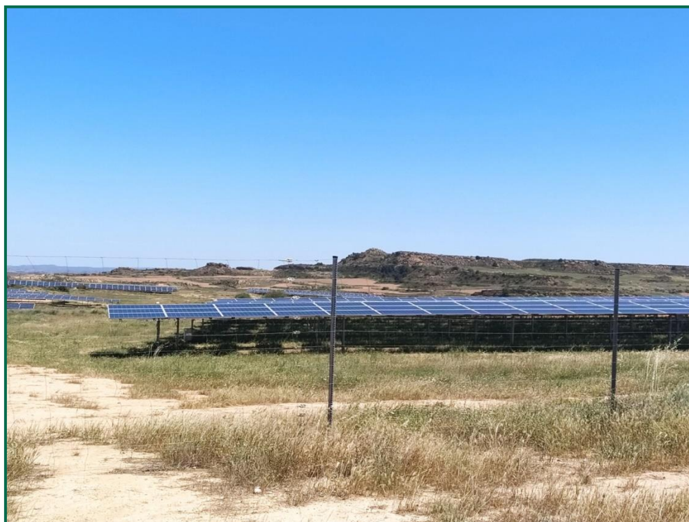
Fotografía 2. Vegetación entre placas actualmente.
